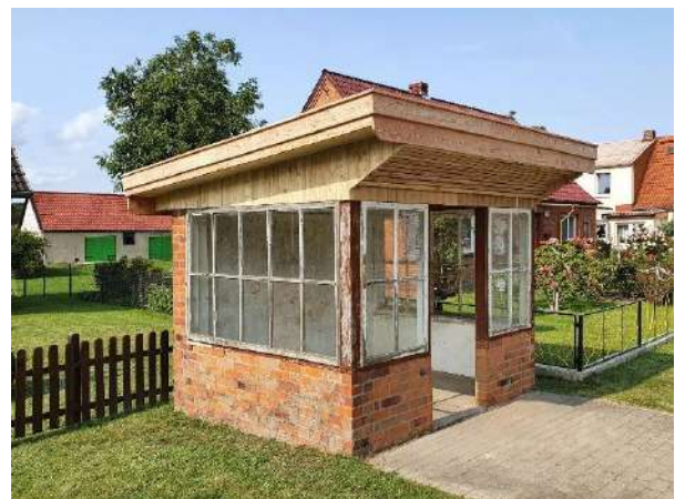
Buswartehäuschen in Stapel, Landkreis Lüneburg Es fehlen noch neue Fenster, Farbe und die Bepflanzung
