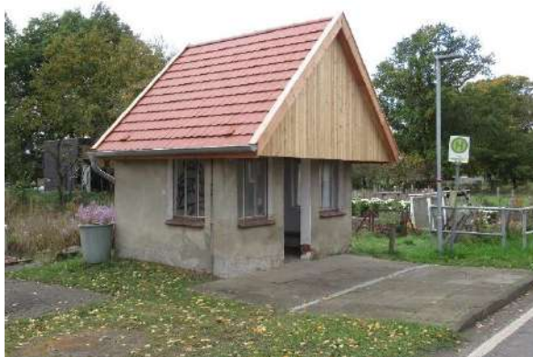
Buswartehäuschen in Sumte, Landkreis Lüneburg Es fehlt noch frische Farbe an den Fassaden und die Bepflanzung
